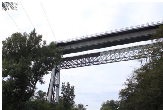
Obr. 96 Železniční viadukt v Ivančicích. Foto: V. Doskočilová
