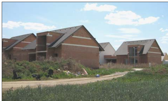
Obr. 50 Příklad výstavby kolonie rodinných domů v Moravanech. Foto J. Žitňáková
