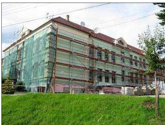
Obr. 83 Dambořice – rekonstrukce základní školy. Foto Z. Lipovská
