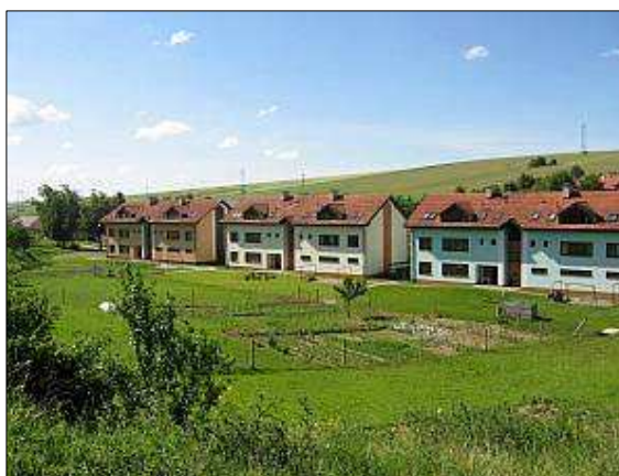
Obr. 84 Dambořice – nová výstavba. Foto Z. Lipovská
