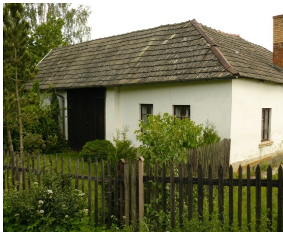
Obr. 3 Stará výstavba Malá Roudka
