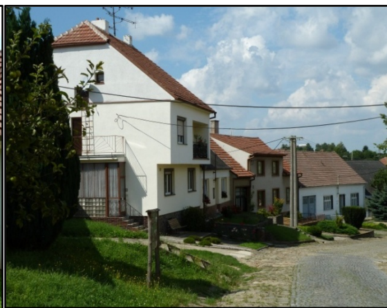
Obrázek 17 Výstavba Bořetice zdroj: vlastní foto
