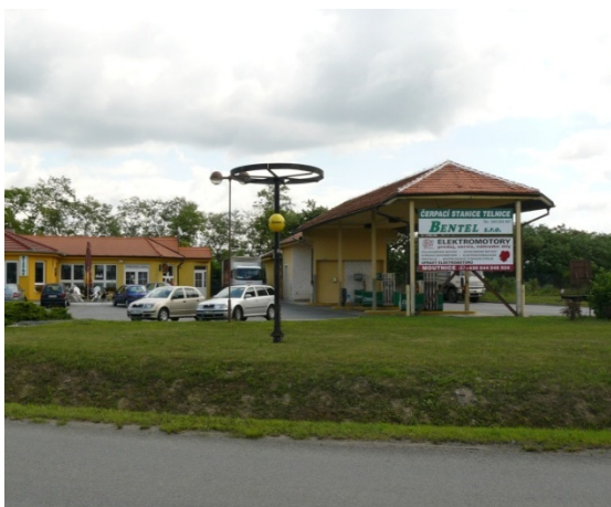
Obr. 21 Čerpací stanice Telnice
