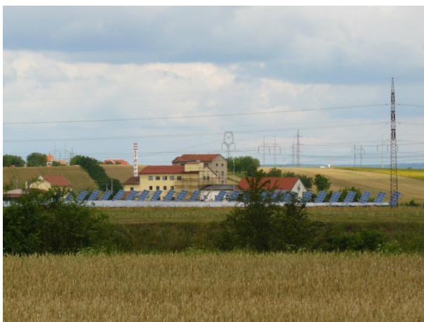
Obr. 27 Fotovoltaická elektrárna Žatčany
