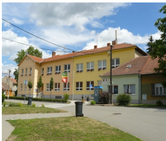
Obr. 6 Obecní úřad a základní škola Kobylnice
